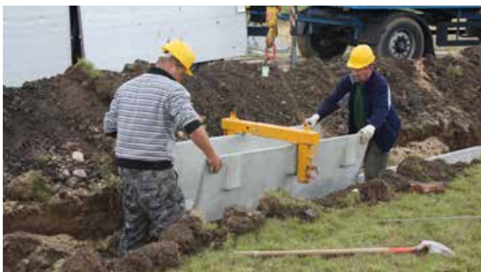
montaj facil prin utilizarea dispozitivului special
