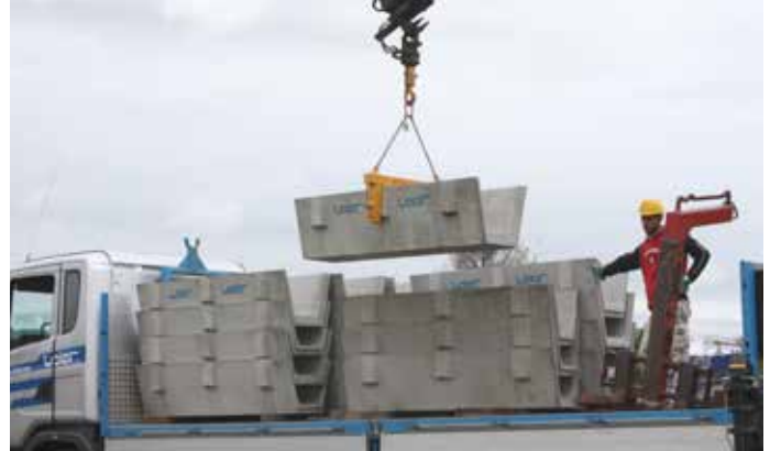
ridicare sigură cu ajutorul dispozitivului special
